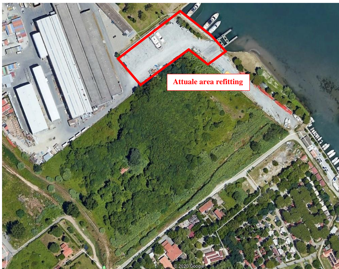
Figura 11 – Area da adibire a refitting, stato attuale dei luoghi (Marina Travel)
